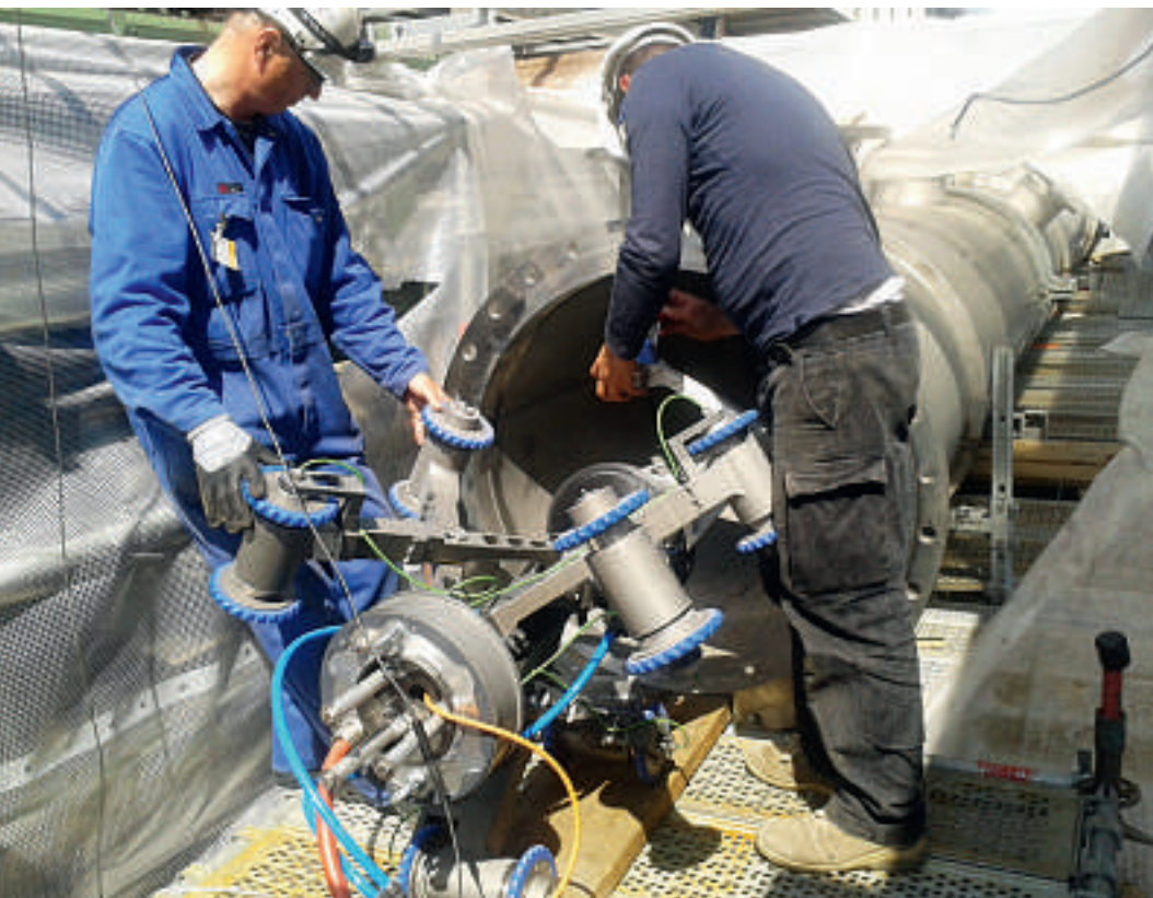
Zuverlässig und schnell inspizieren IBASS-Roboter auch geflutete Rohre bis in 20 m Tiefe von innen, beschleifen Oberflächen oder bergen Objekte. (Bild: IBASS)
