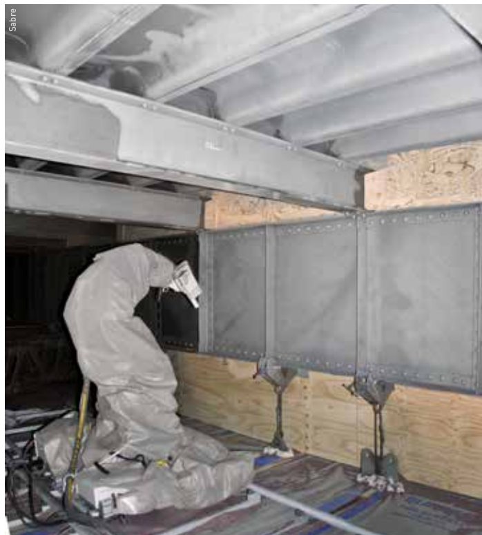
Der Sandstrahlroboter der Sabre Autonomous Solutions fräst völlig autonom Schmutz, Rost und alte Farbe von Stahlträgern. Ein Kinect Sensor und spezielle Algorithmen berechnen ein Mapping-System für den exakten Bahnverlauf der Sandstrahlpistole und verhindern so Kollisionen.
